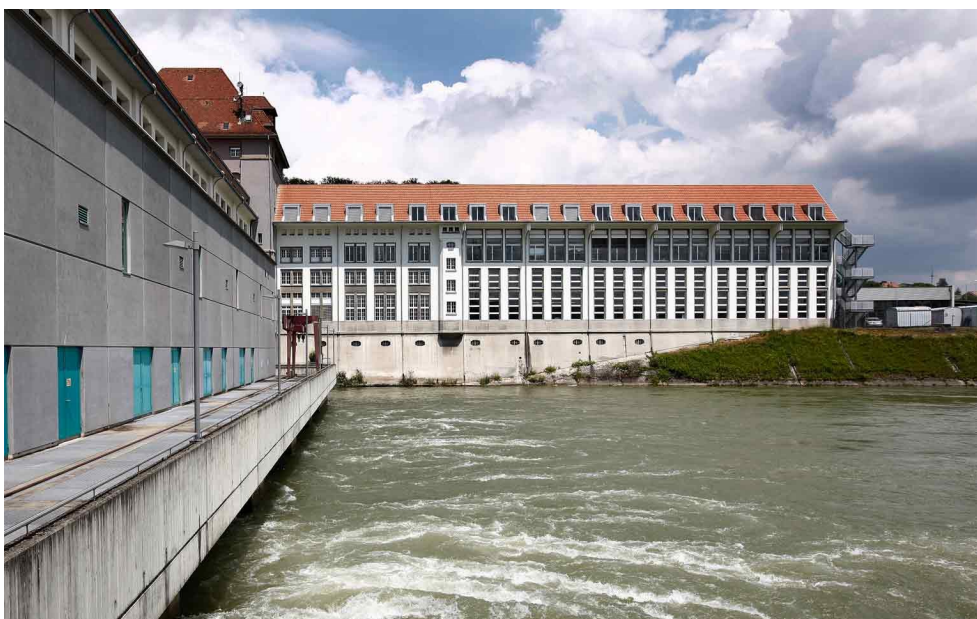
La nouvelle concession pour la centrale hydroélectrique de Gösgen est valable jusqu'en 2089.
