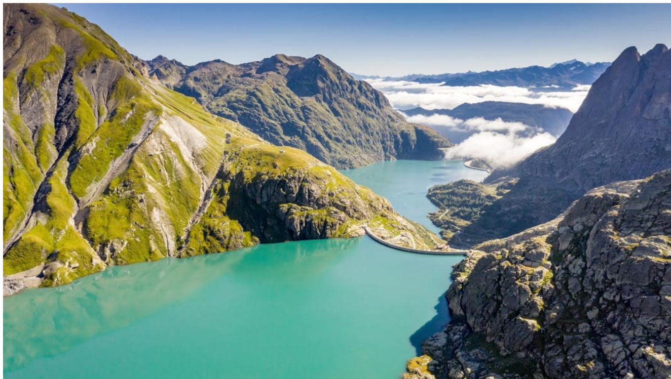
La centrale de pompage-turbinage de Nant de Drance dans les Alpes valaisannes. Au premier plan le barrage du Vieux Emosson, et 295 mètres plus bas celui d'Emosson. Photo : Sébastien Moret
